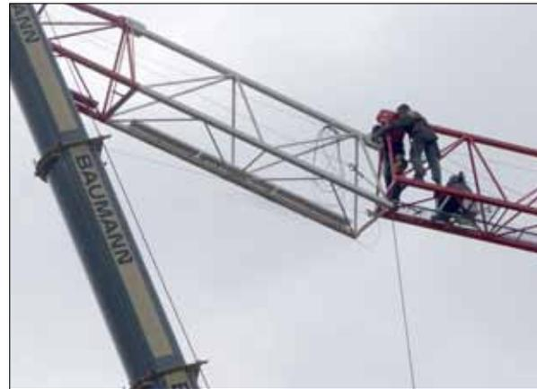
Atemberaubend und spannend war es zu beobachten, wie der Drehturmcran montiert wurde. In 30 m Höhe nahmen zwei Kranmonteure die einschwebenden Teile entgegen und fügten sie zusammen. Derweil wurden am anderen Ende der Baustelle tiefe Löcher gebohrt, in die Stahlträger zur Stabilisierung der Baugrube versenkt wurden. DL
